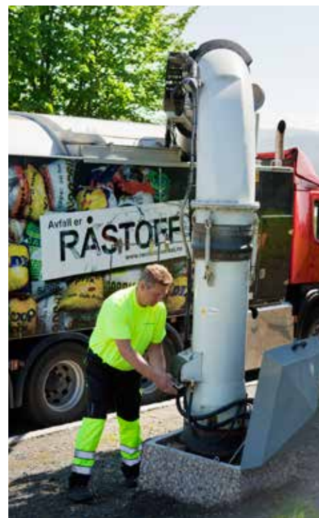
Renovasjonsbilen kobles til et dokkingpunkt og avfallet suges fra avfallstankene og inn i bilen.
